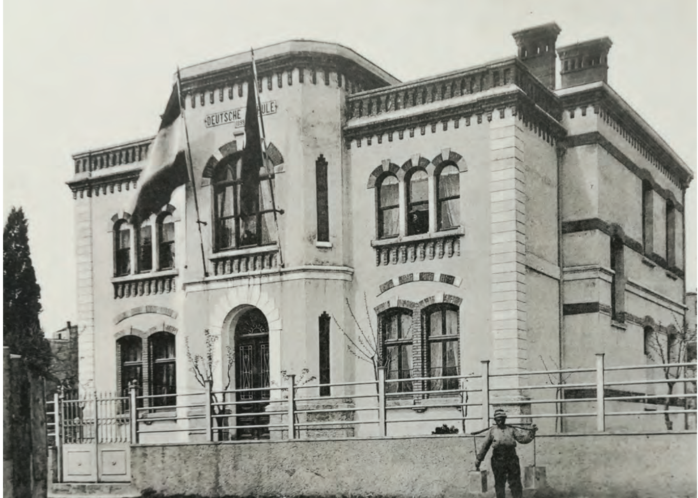
1903 Yedikule Okul Binası
